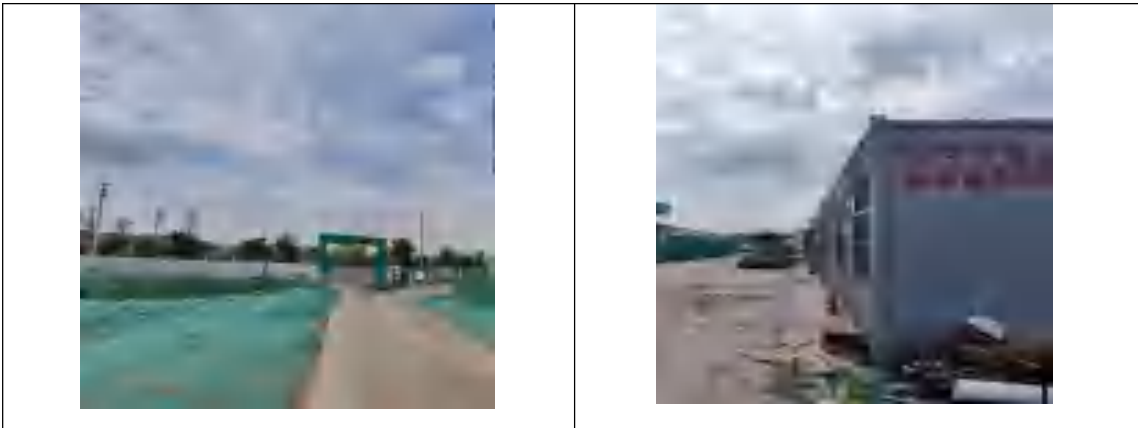
图 2.2-2 施工道路现状
