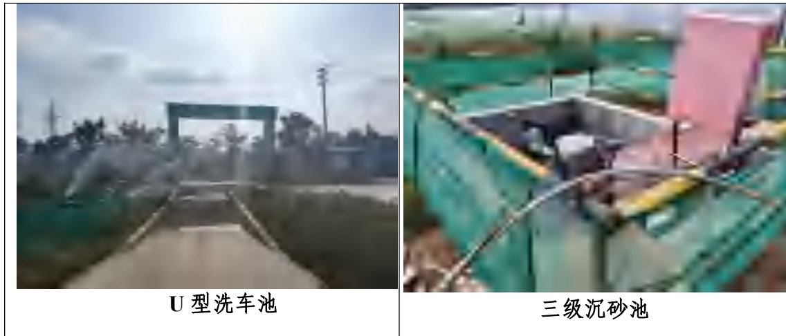
图 4.4-1 现场调查照片
